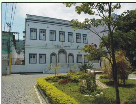
Figura 27 - Prédio da Prefeitura Municipal.
