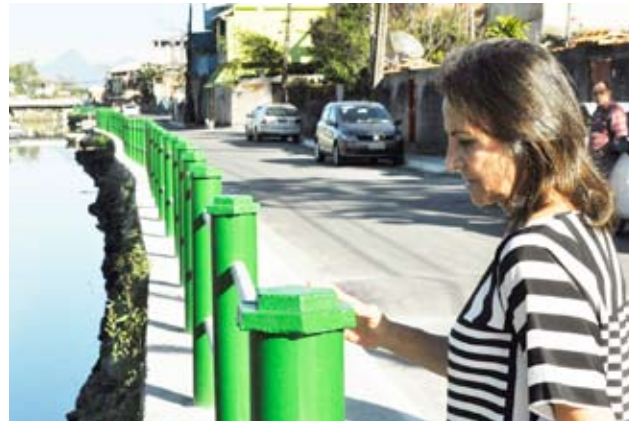
A prefeita Conceição visitou a obra
